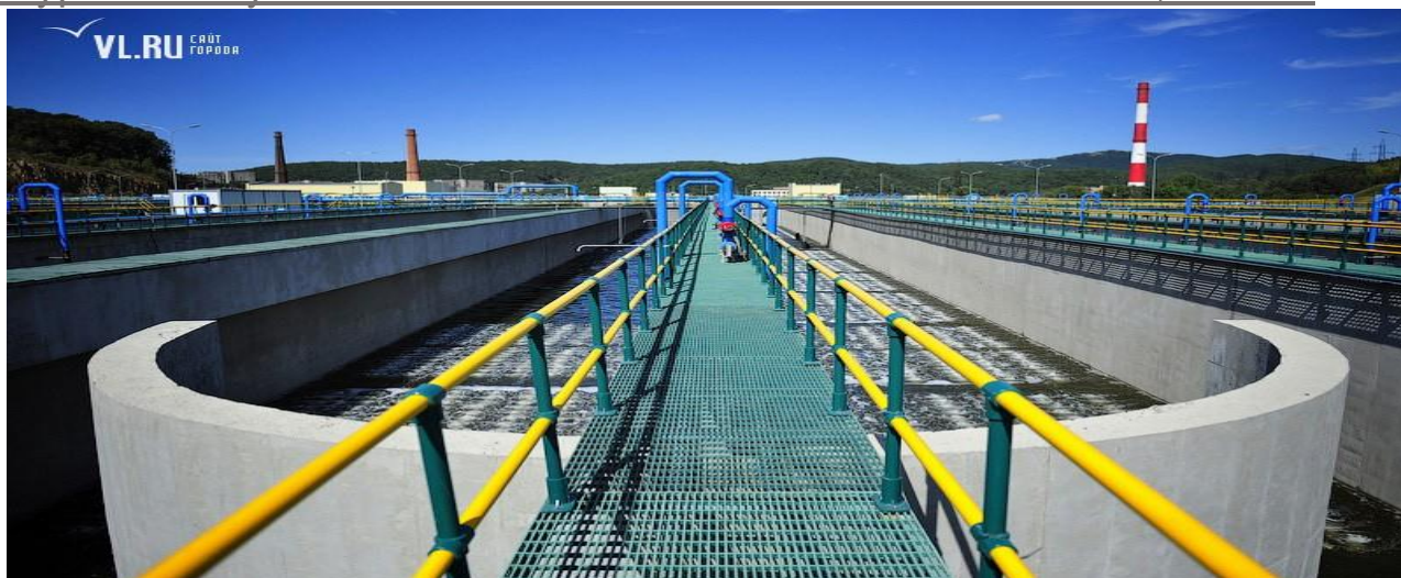
Рисунок 2. Владивосток. Городские очистные сооружения сточных вод
