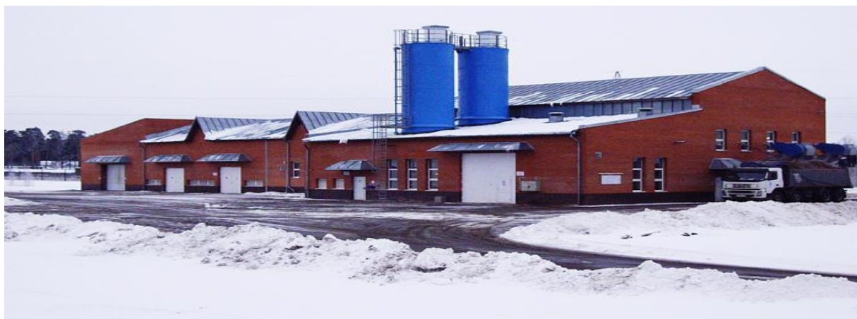
Рисунок 5. Южное Бутово. Очистные сооружения производительность 80 тыс.м3/сут
